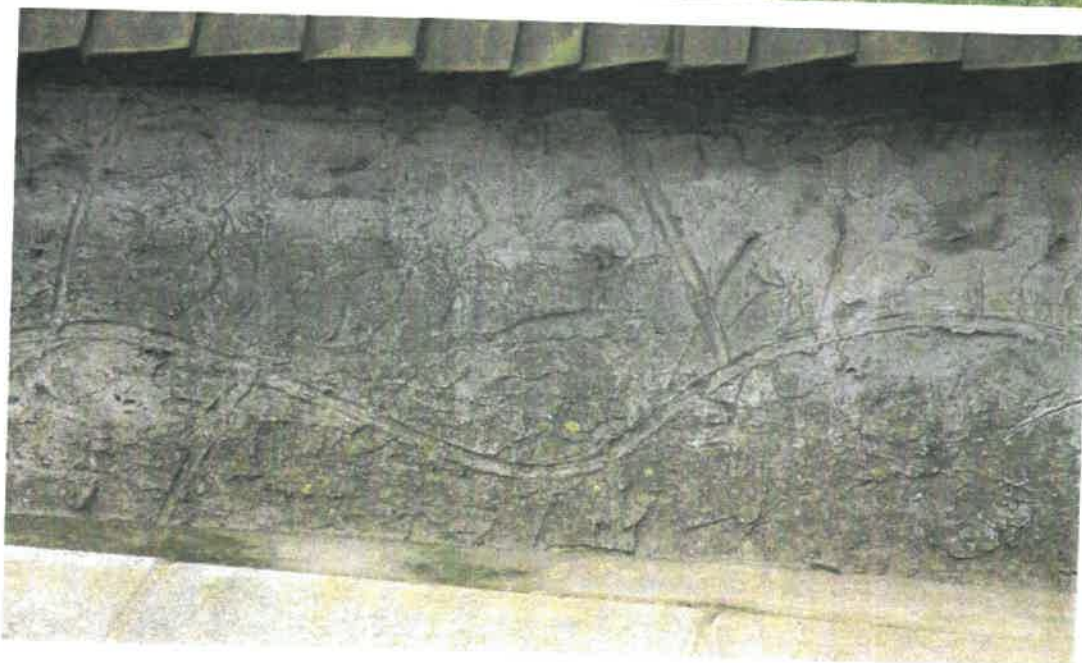
Fot. nr 15 i 16. Kościół parafialny pw. Świętego Stanisława BM w Skrzyszowie. Stan przed konserwacją. Fot. Tomasz Głowacz
