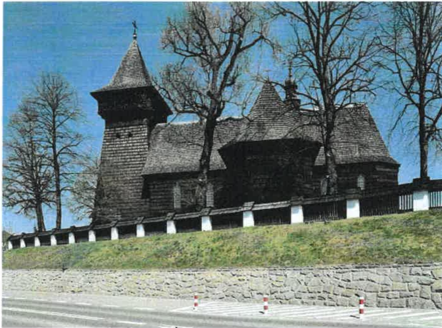
Widok od strony południowej
