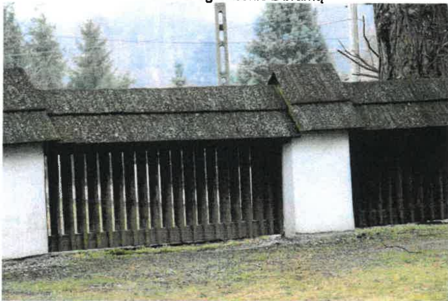
Widok na ogrodzenie
